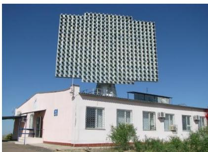
Рис. 3.4.19. Приёмная антенна космической связи на космодроме Байконур; эффективная площадь почти 200 м<sup>2</sup>
